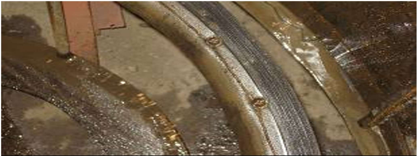
Рисунок 2.14 – Нижнее вращающееся кольцо гидроуплотнения ЦОМ после окончания стендовых испытаний
