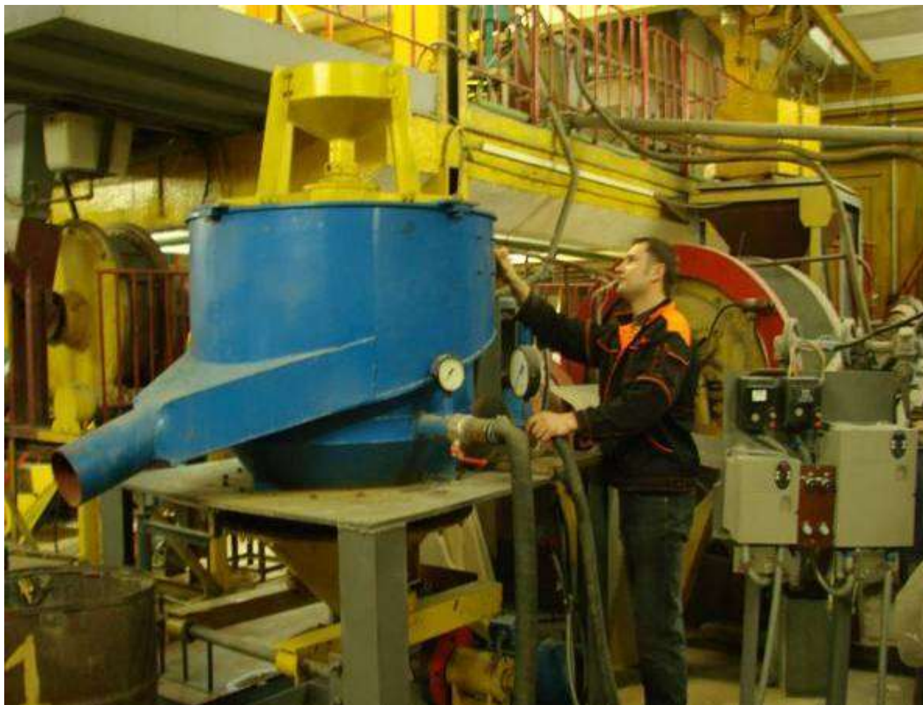
Рисунок 2.4 – Размещение ЦОМ на полузаводской установке ОАО «Иргиредмет»
