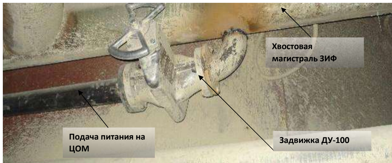
Рисунок 2.7 – Отвод хвостов для питания ЦОМ из хвостовой магистрали ЗИФ
