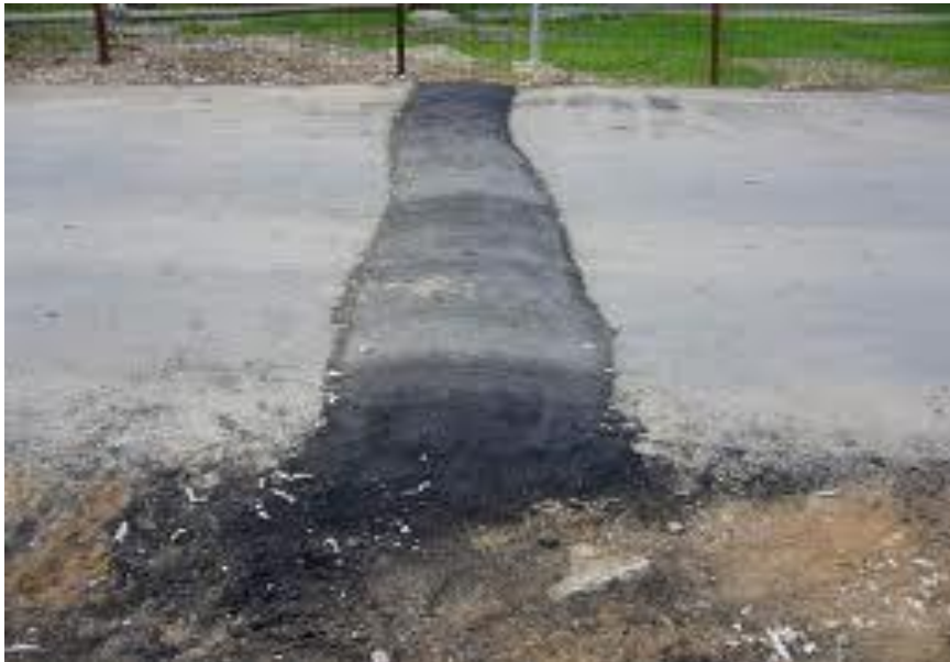
Рисунок 2 – Монолитная искусственная дорожная неровность
