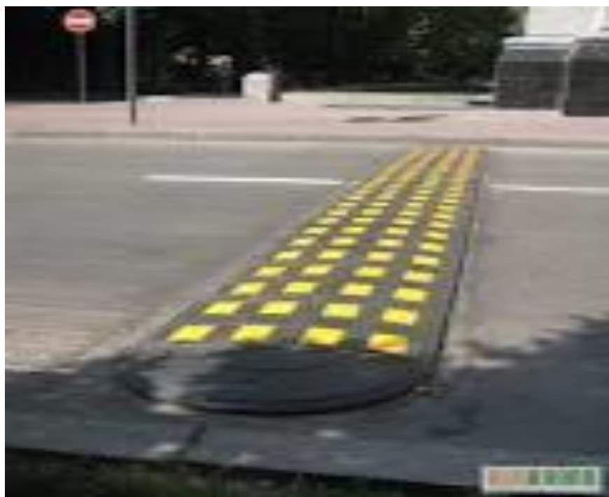
Рисунок 1 – Сборно-разборная искусственная дорожная неровность
