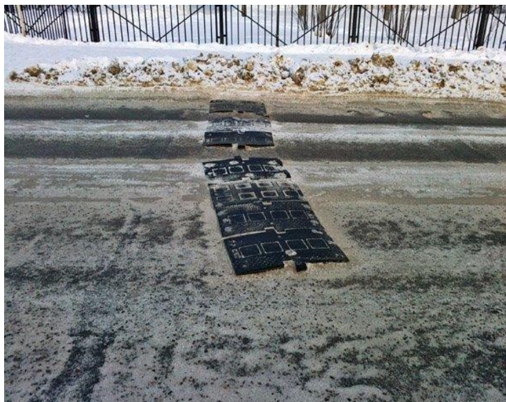
Рисунок 3 – Повреждения ИДН(а,б)
