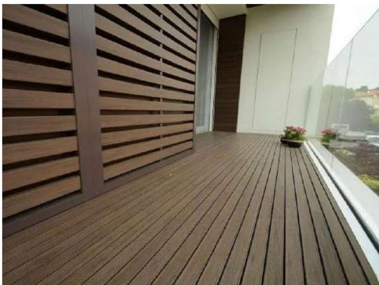
**Рисунок 34. Настил балкона планкеном**
