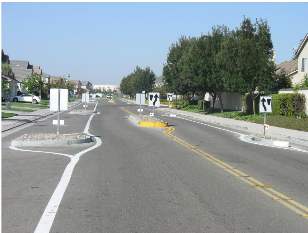
Рис. 1. Применение крутых поворотов-чикэнс (chicanes)
