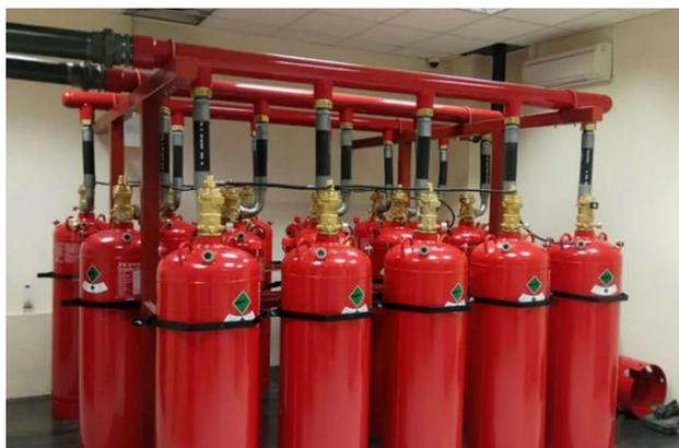
Рис. 1. Установка пожаротушения на основе «сухой воды»
