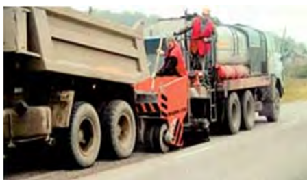
Рис. 3. Совместная работа автогудронатора и битумощебнераспределителя
