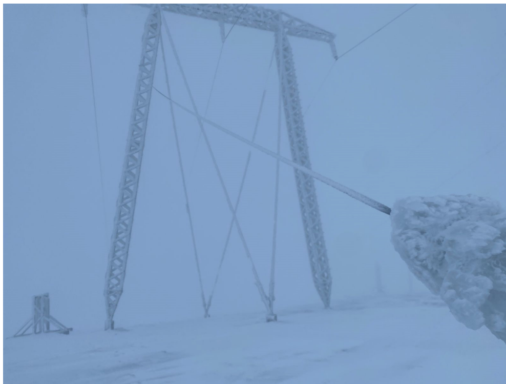
Рисунок 1. Гололёдообразование на участке ВОЛС
