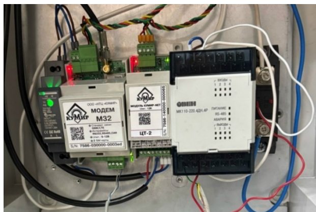
Рисунок 3. Модем M32 для передачи данных по каналу GSM
