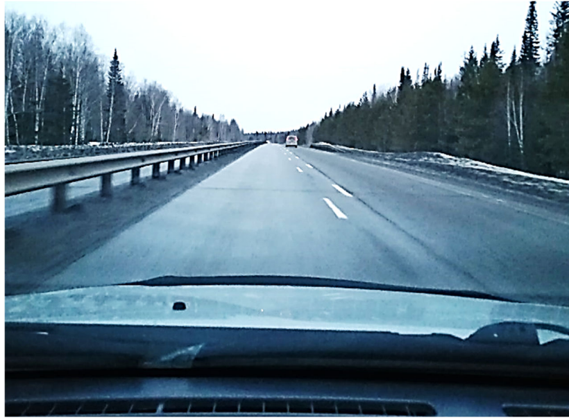
Рисунок 3.6 – Осмотр проезжей части
