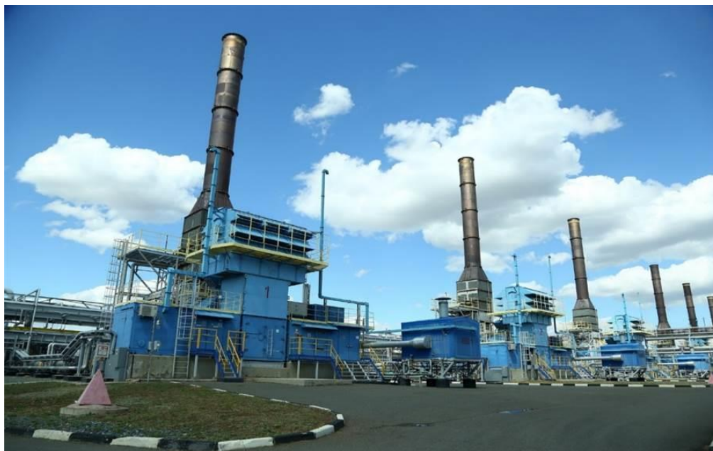
Рисунок 2.2.6 – Объект мониторинга № 4 – компрессорная станция
