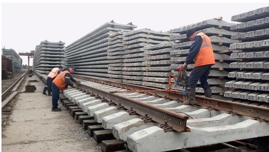
***Рис. 10. Зашивка уравнительных пролетов на инвентарных рельсах длиной 12,5 метров после внедрения бережливого производства***
