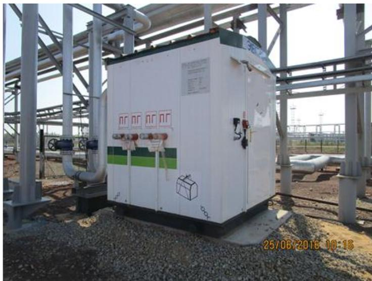
*Рис. 2. Наземный узел пожарных гидрантов*
