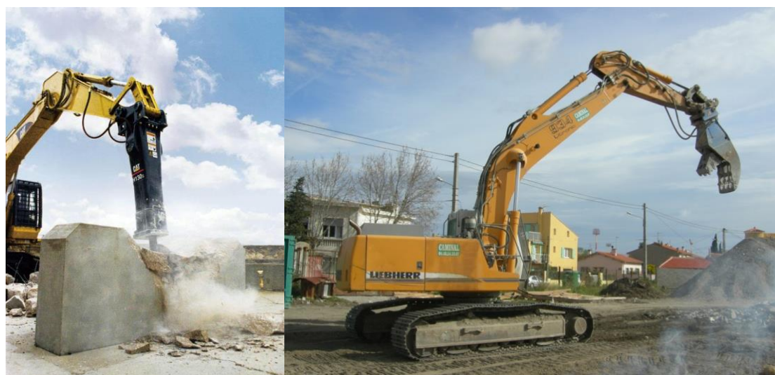
Рисунок 1. Механизмы для разрушения элементов зданий.
