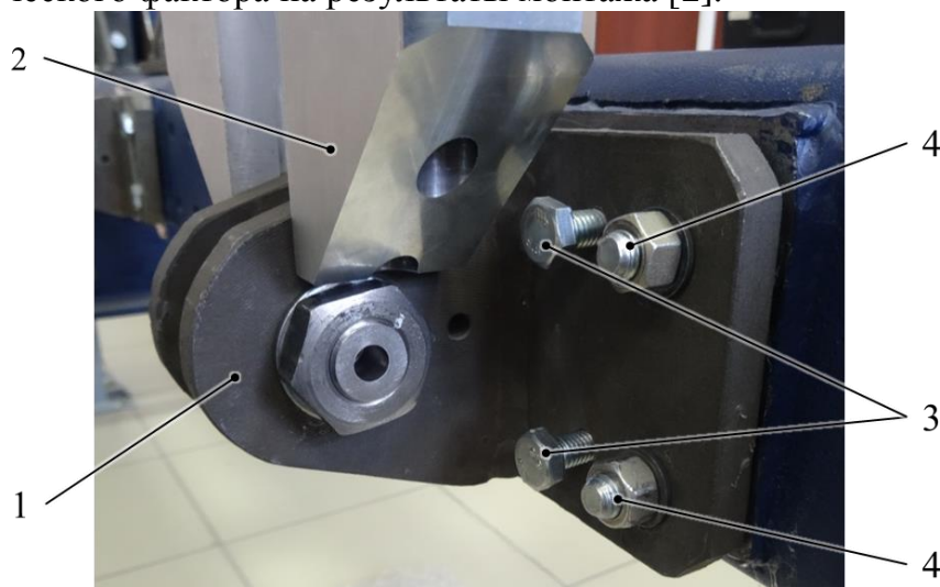
Рис. 1. Монтаж кронштейна на домкратных винтах
