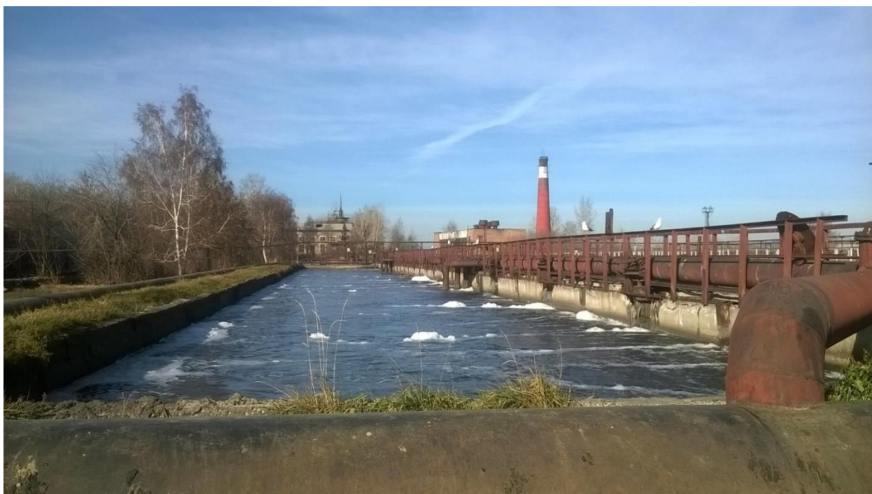
Вид очистных сооружений левого берега г. Иркутска
