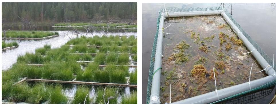
**Рисунок.** Плавающее биоплато для очистки сточных карьерных вод от минеральных соединений азота
