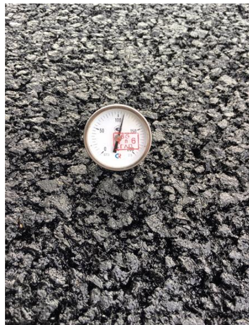
Рис.3 Температура теплой асфальтобетонной смеси, уложенной в покрытие
