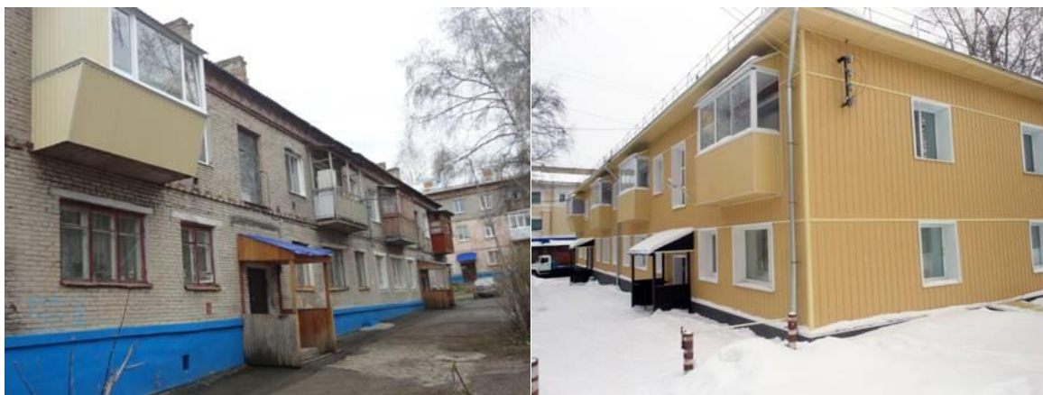
Рис. 1 - Фасад дома до и после реконструкции
