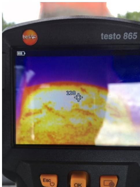
Рис.2 Температура теплой асфальтобетонной смеси при выгрузке из самосвала в бункер асфальтоукладчика
