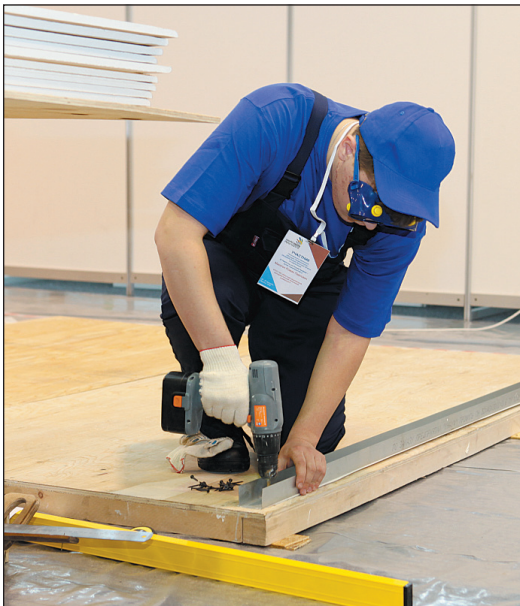
Первый чемпионат «Молодые профессионалы» в Иркутской области, 2016 г. Номинация «Сухое строительство и штукатурные работы»
