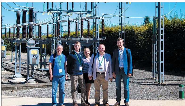
Экскурсия на подстанцию компании Schneider Electric
