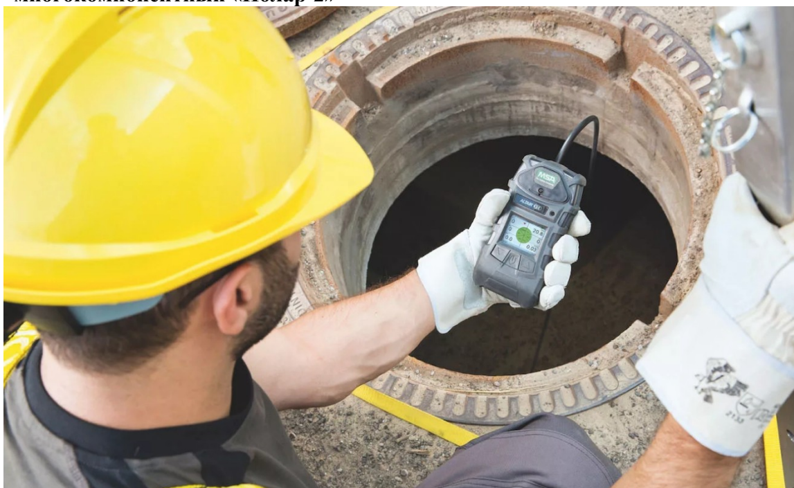
Рис. 3.6. Проверка колодца на загазованность
