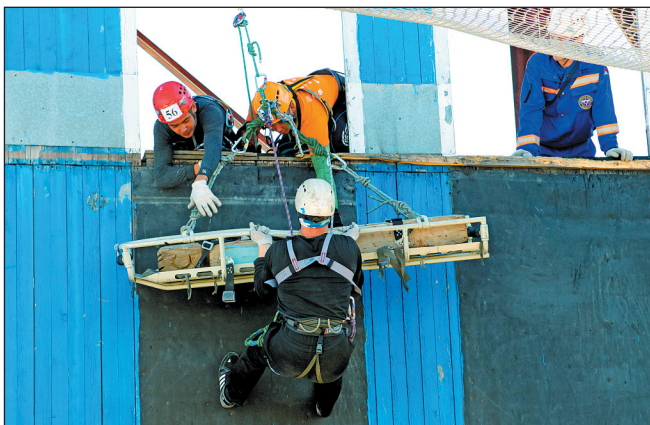
Ребята из «ПолиСпаса» эвакуируют манекен из разрушенного здания
