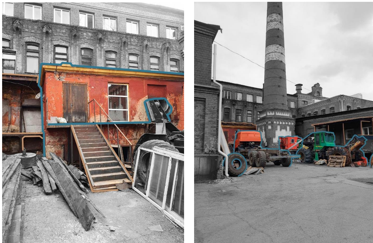
Рис.46. Фотофиксация внутреннего двора. Существующая входная группы в главный корпус.
