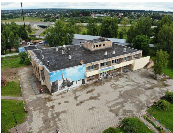
Рис.1.17. Здание до реконструкции
