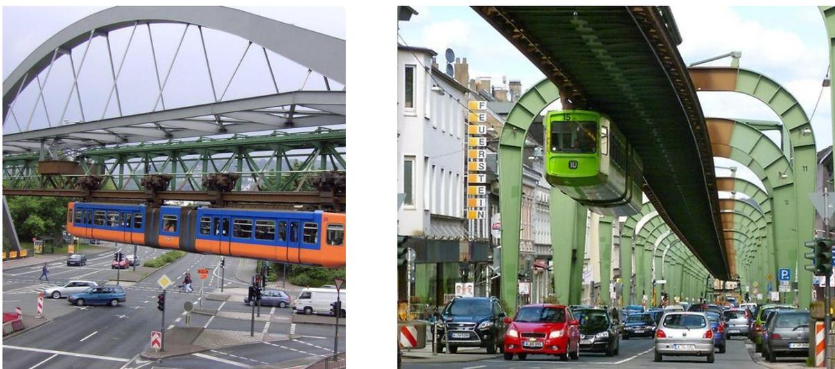
Рис. 2 – Варианты размещения монорельса над проезжей частью
