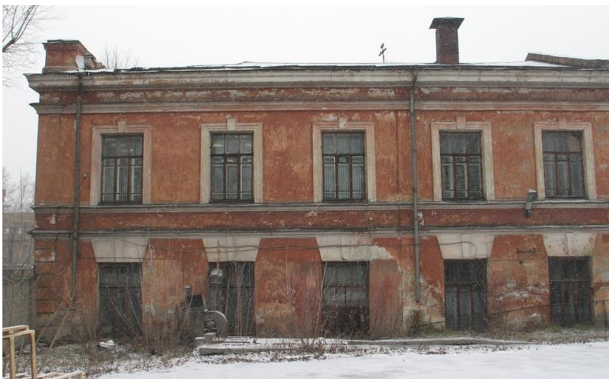
Фото 16. Южный фасад (двор).
