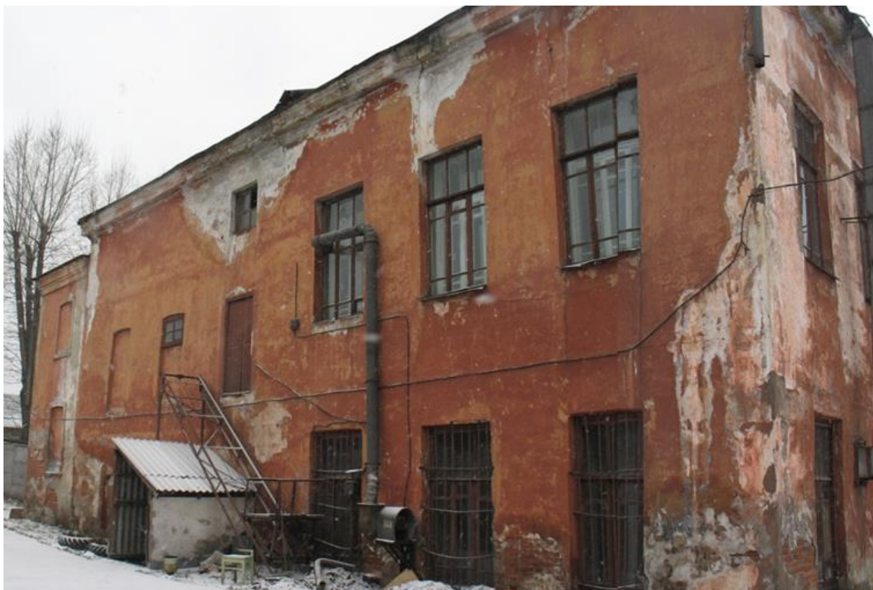
Фото 9. Восточный фасад (двор).
