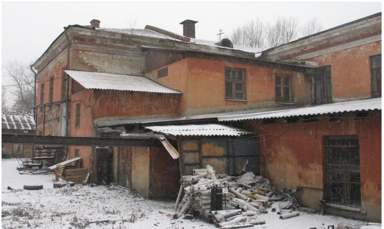
Фото 14. Северный фасад (двор).
