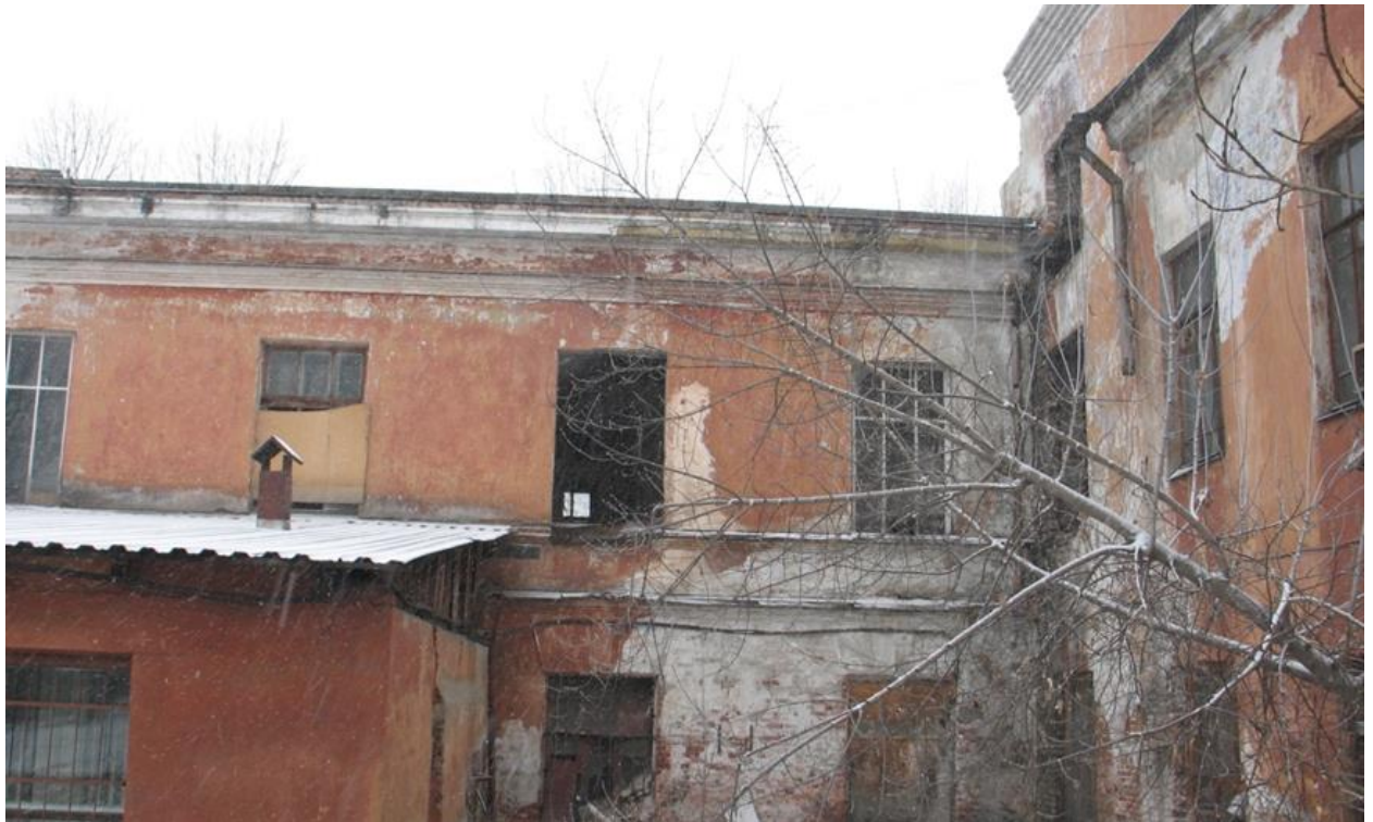
Фото 13. Восточный фасад (двор).
