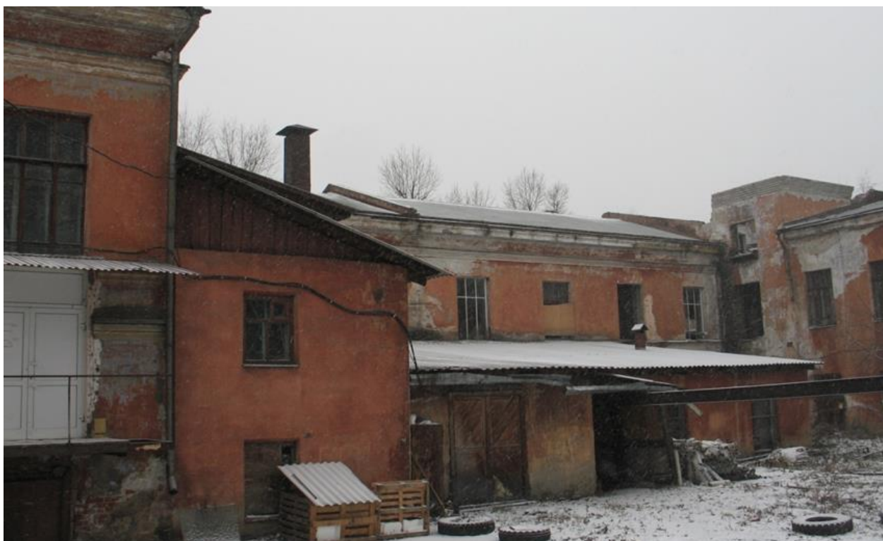
Фото 12. Восточный фасад (двор).
