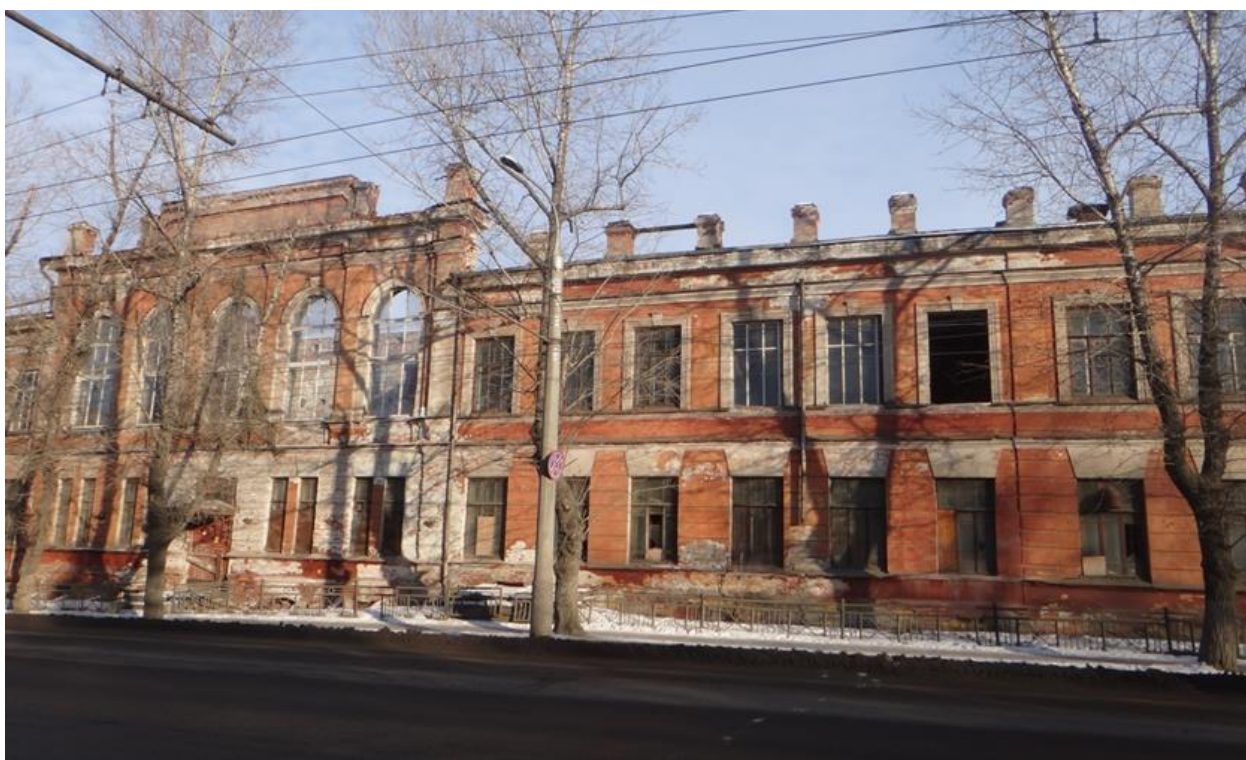
Фото 4. Главный фасад по ул. Рабочего штаба (Южное крыло).
