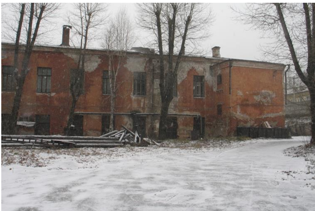
Фото 10. Южный фасад (двор).
