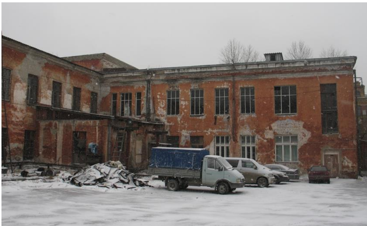
Фото 6. Восточный фасад (двор).
