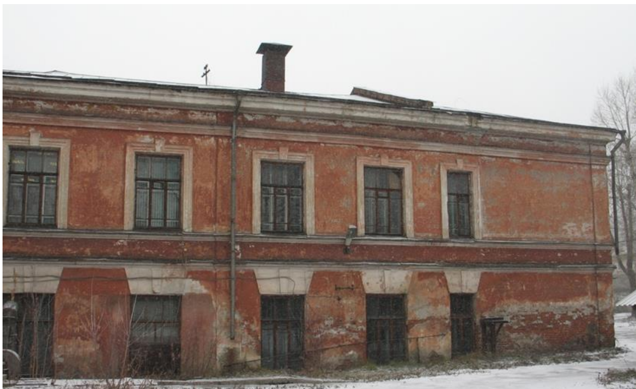
Фото 17. Южный фасад (двор).
