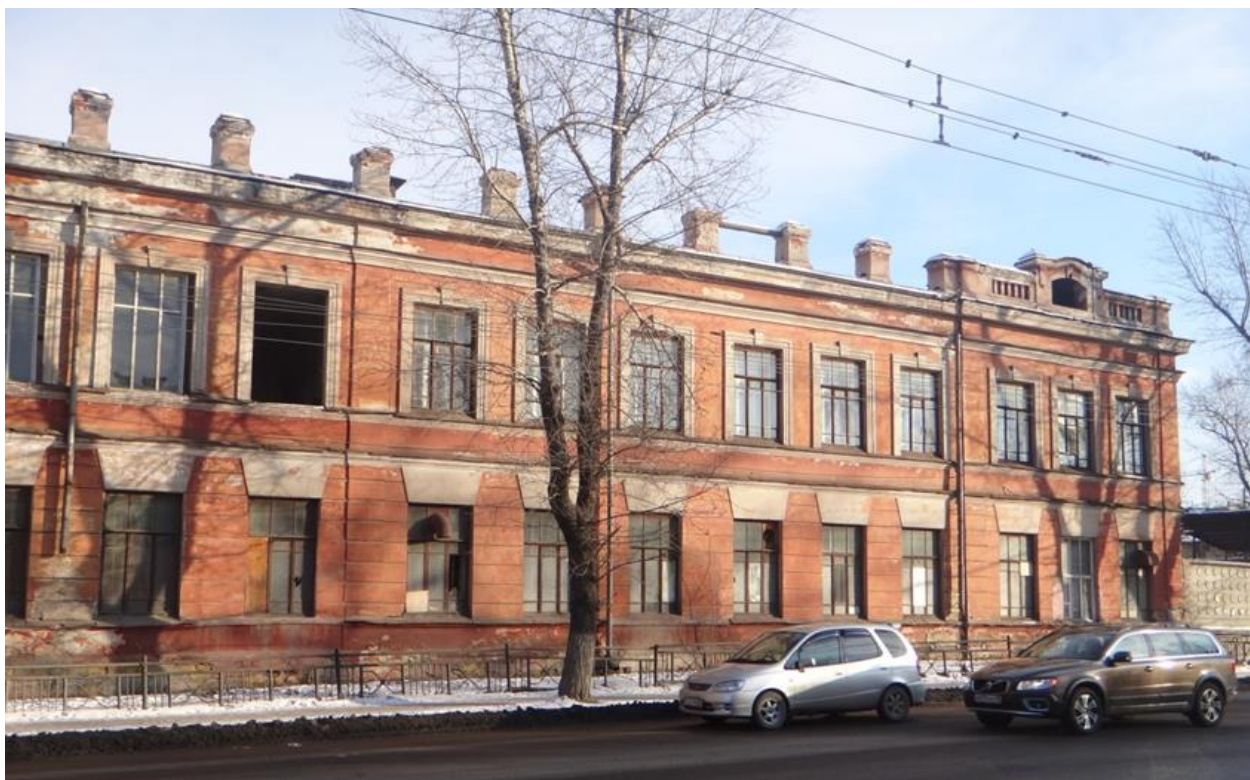
Фото 5. Главный фасад по ул. Рабочего штаба (Южное крыло).
