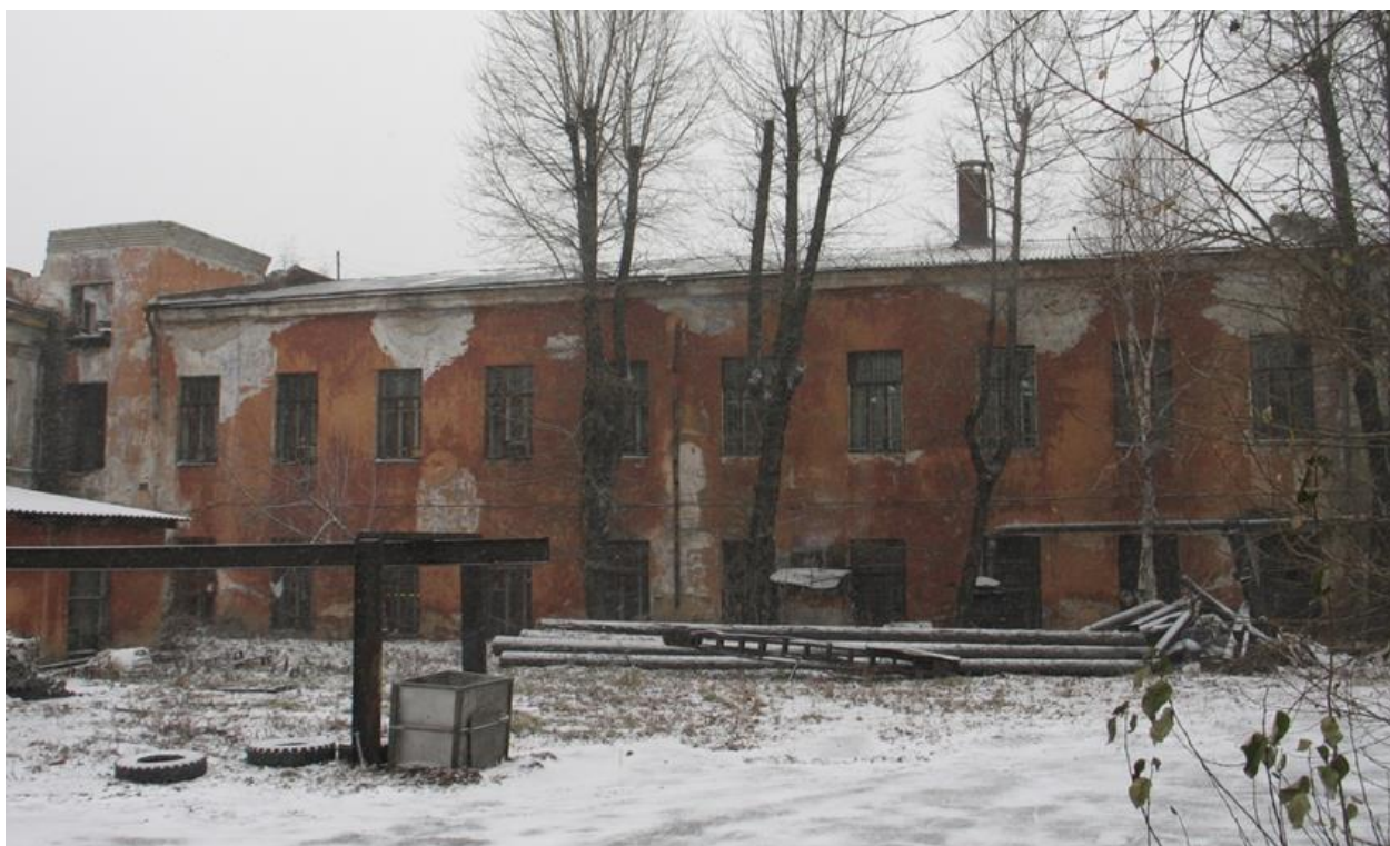
Фото 11. Южный фасад (двор).
