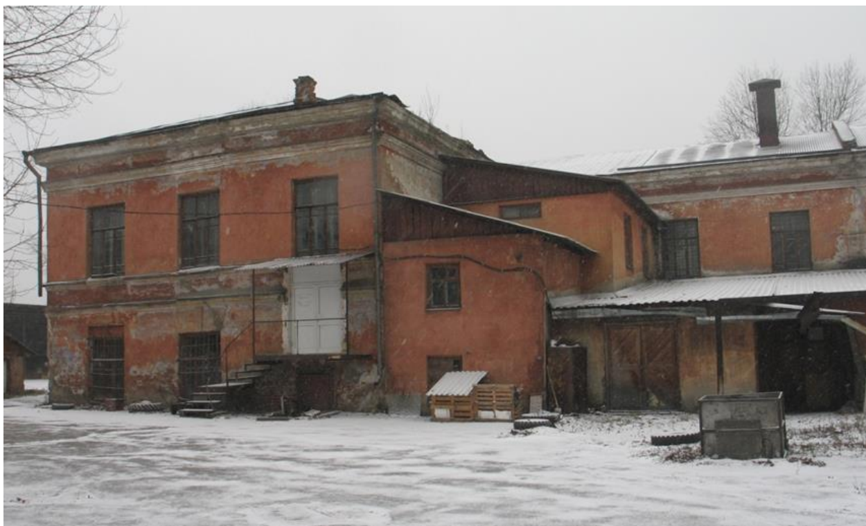
Фото 15. Восточный фасад (двор).
