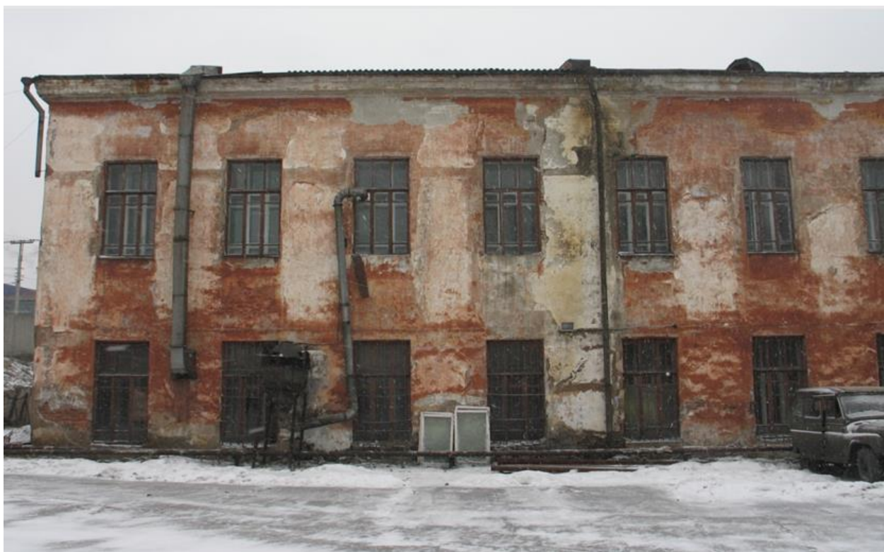
Фото 7. Северный фасад (двор).
