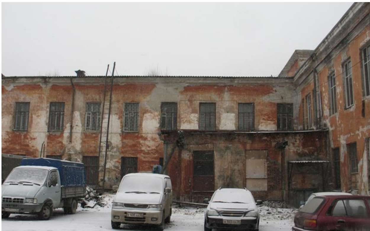
Фото 8. Северный фасад (двор).
