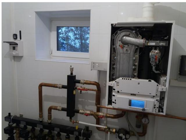
Рисунок 2- ИТП с погодозависимой автоматикой.
