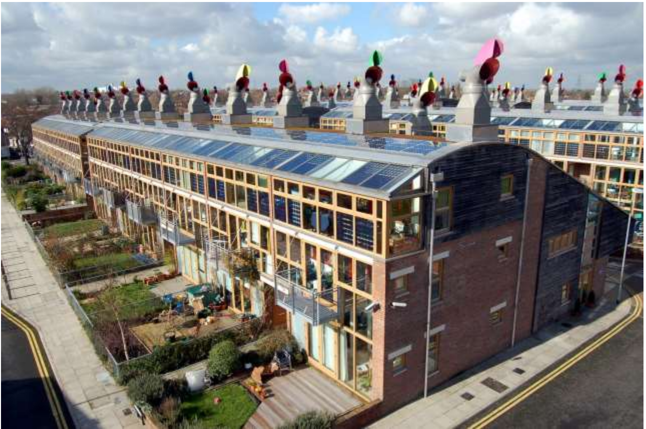
Рис. 2. Энергоэффективный квартал BED ZED в Лондоне, архитектор Билл Данстер. 2002 г.
