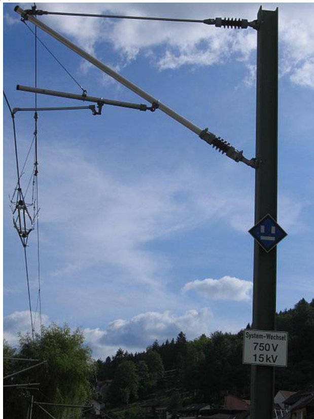
Рисунок 3 – Место перехода с 750 В на 15 000 В (переход с трамвайной на железнодорожную контактную линию)
