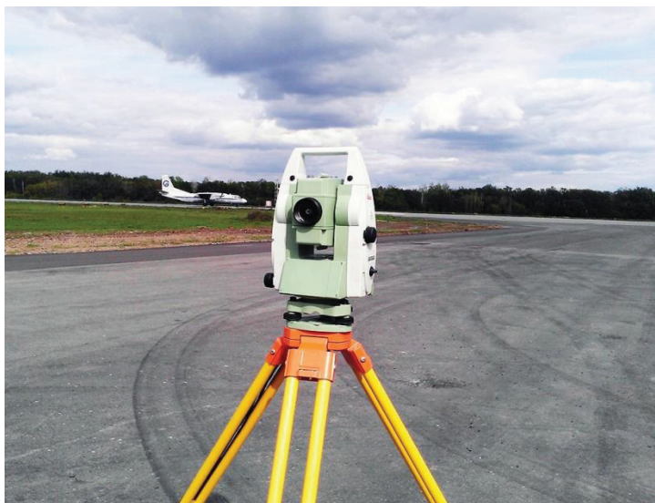
Рис. 1. Ведение топографо-геодезических работ на взлетно-посадочной полосе
