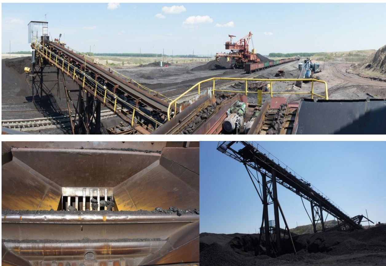
Рисунок 2.20 Склад и сортировка угля. Разрез Переясловский
