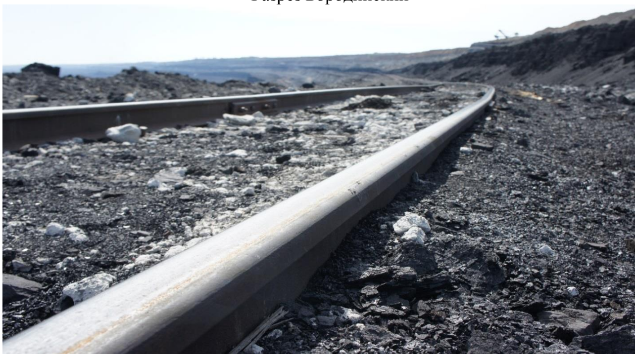
Рисунок 2.14 Скопления угольных просыпей при погрузке в ж/д в/вагоны. Разрез Бородинский
