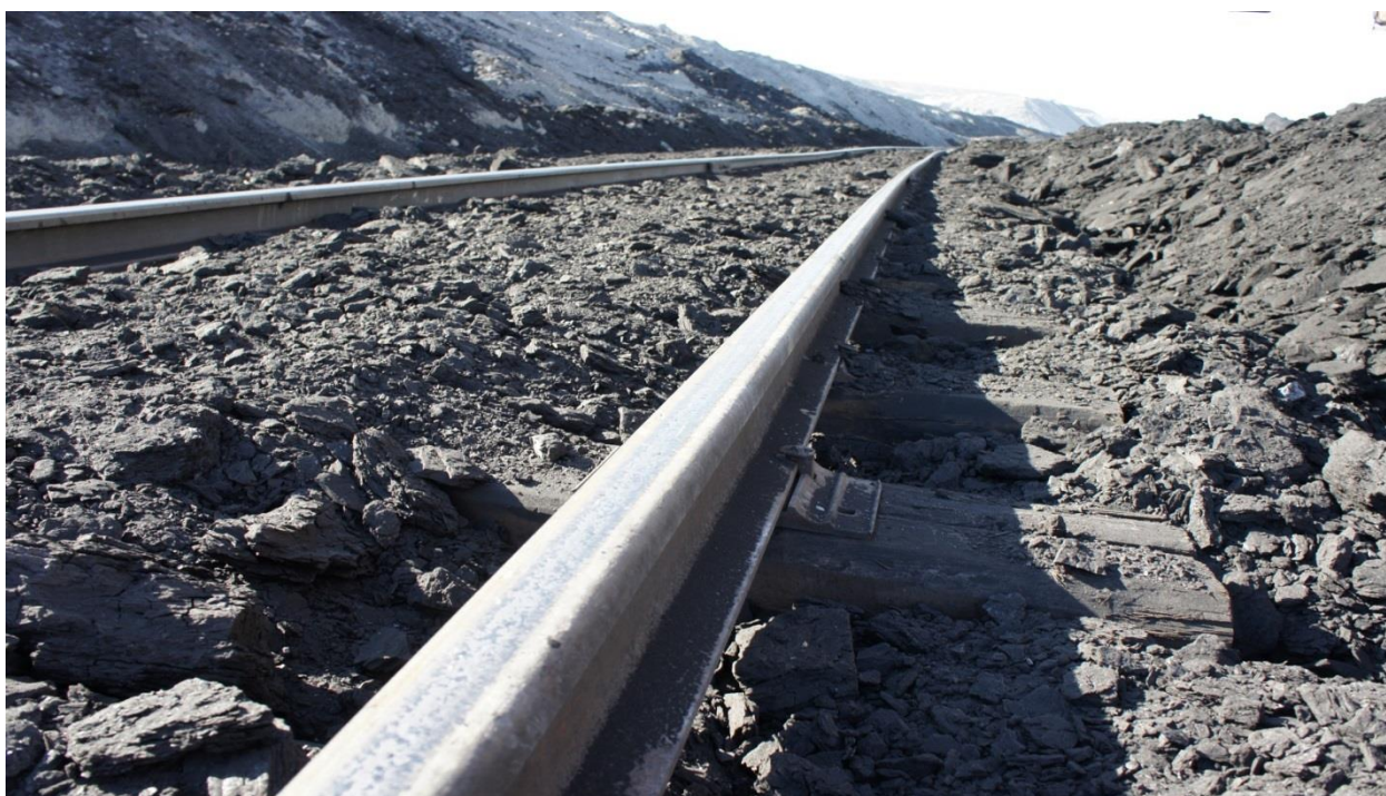
Рисунок 2.36 Скопление угольной мелочи при погрузке в ж/д п/вагоны. Разрез Харанорский
