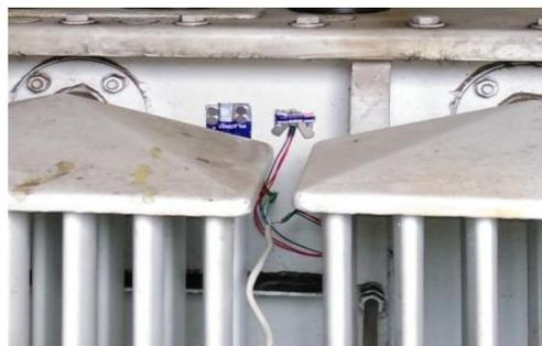
Разработан измерительный комплекс для мониторинга остаточного ресурса работы силовых трансформаторов на основе контроля температуры и фиксации температурных перегрузок трансформатора с последующим расчетом остаточного ресурса работы трансформатора.
