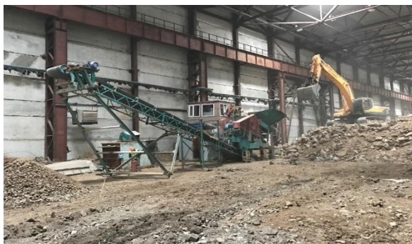
Рисунок. 2 – Измельчение отходов из бетона.
