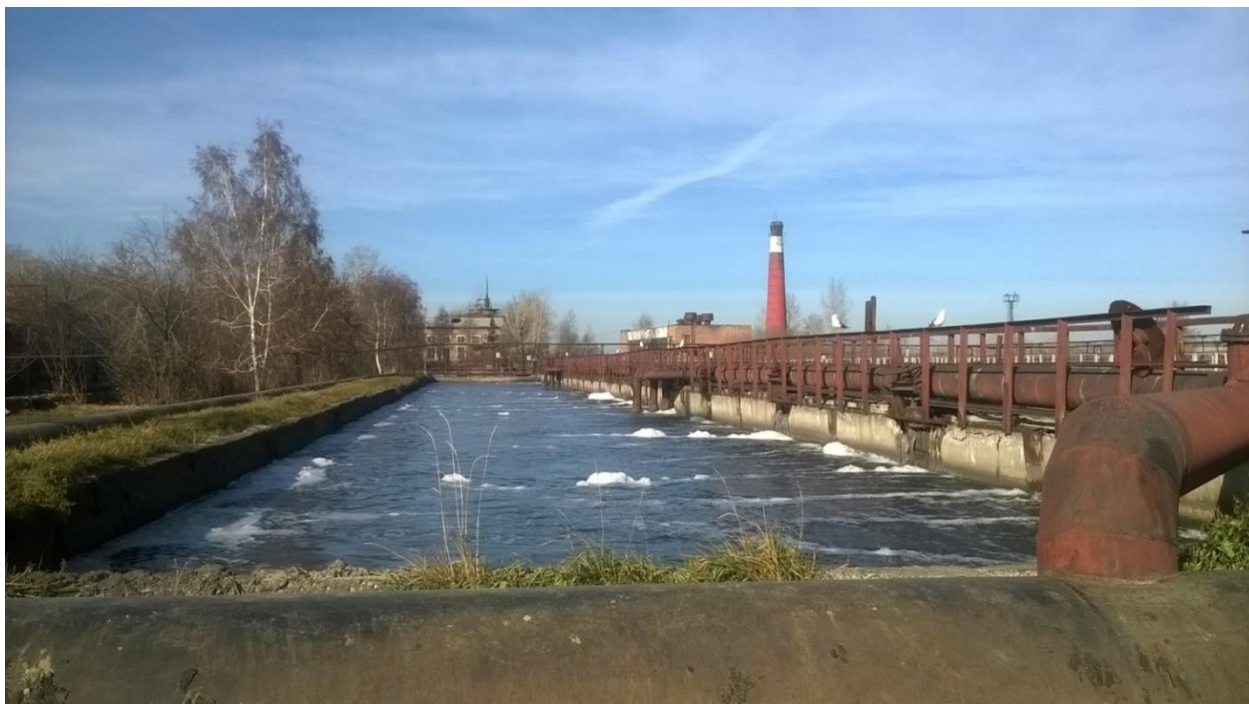
Вид очистных сооружений левого берега г. Иркутска
