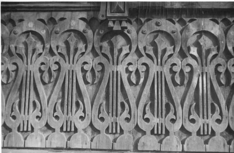
Ул. Карла Либкнехта, 111. Жилой дом кон. XIX — нач. XX вв. Декор подоконного пояса.
