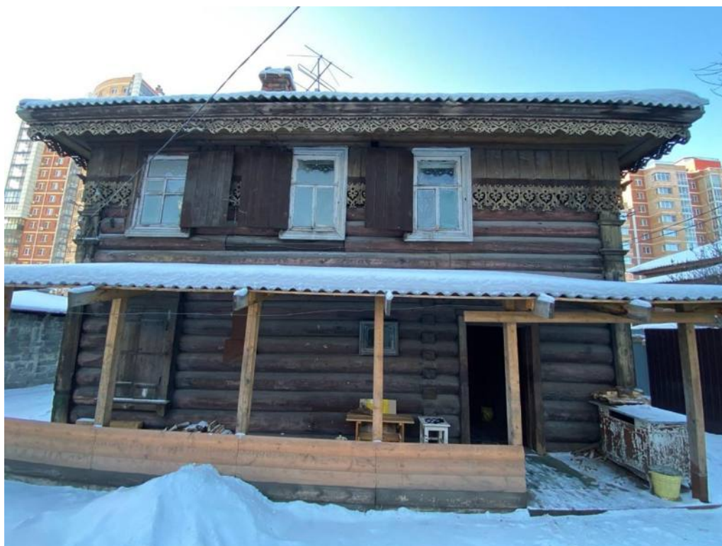
Дворовой (северо-восточный) фасад
