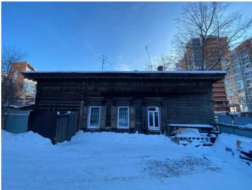
Боковой (северо-западный) фасад
